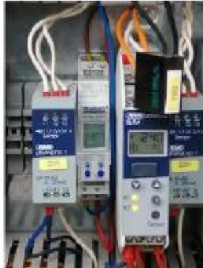
Timer op bitumentanks en beperking temperatuur. Maximale opwarming tijdens de nacht (nachttarief).
