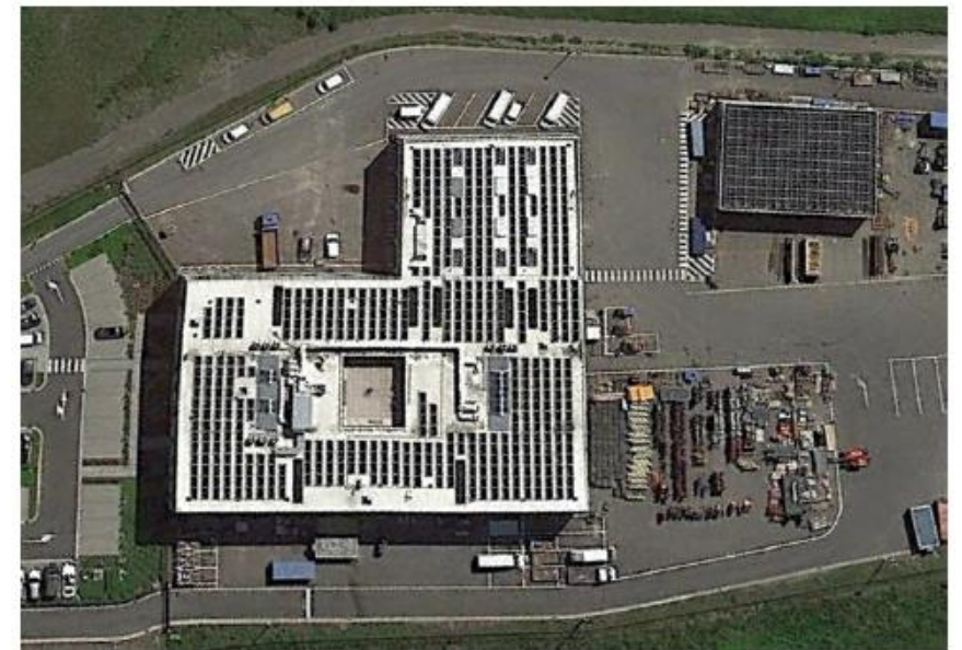
PV-installatie hoofdkantoor + bijgebouw
