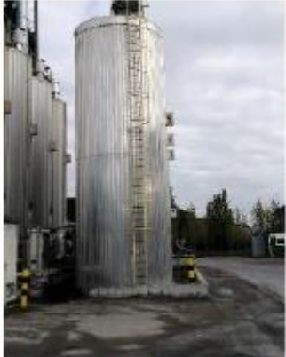
Timer op bitumentanks en beperking temperatuur. Maximale opwarming tijdens de nacht (nachttarief).
