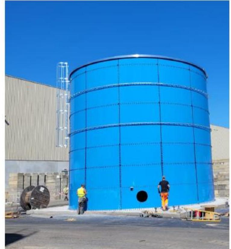
Opvang hemelwater op onze nieuwe betoncentrale (tank 655 m<sup>3</sup>)
